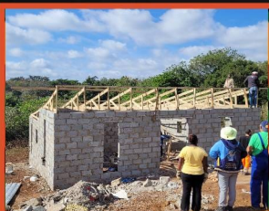
Das Jugendzentrum entsteht
